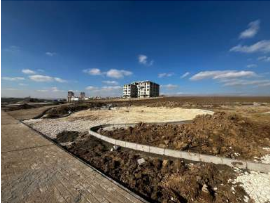
Şekil 263 TOKİ YOLU PARK İNŞAATI
